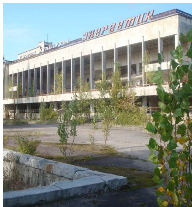
Obr. 19 Chátrajúci Palác kultúry Energetik v Pripjati.
