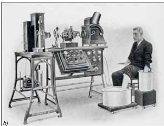
Obr. 2.5. - Počátky měření elektrické aktivity srdce: holandský vědec Willem Einthoven (1860-1927) – a, technická stránka prvních přístrojů zaznamenávajících EKG (b)
