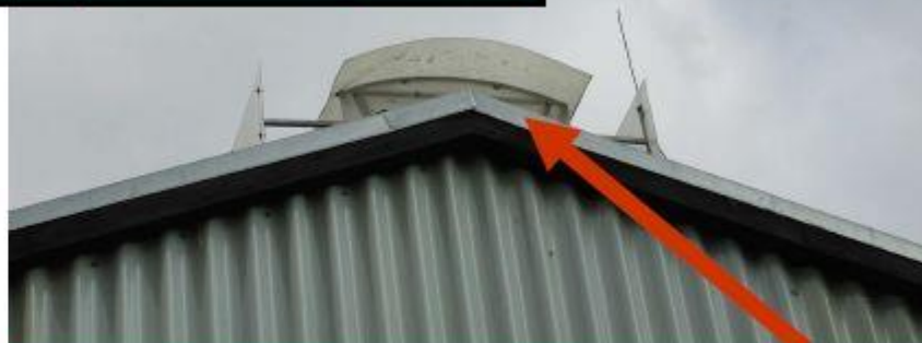
HŘEBENOVÁ ŠTĚRBINA 1 m rozponu stáje – 2,5 cm šířky štěrbin
