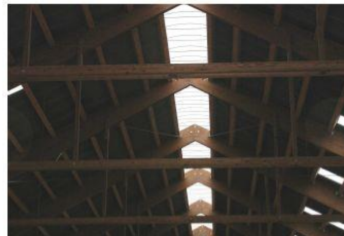
HŘEBENOVÁ ŠTĚRBINA 1 m rozponu stáje – 2,5 cm šířky štěrbin
