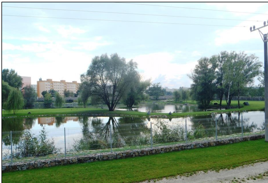
Obr. 1 – Celkový pohled na oplocený areál rybníků.
